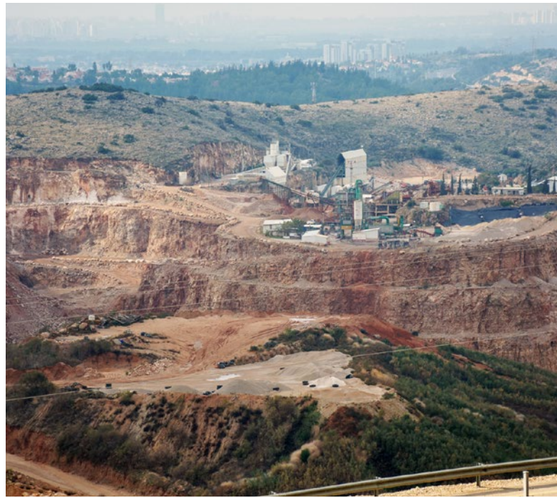
Der Nahal Raba-Steinbruch. Foto: Al-Haq, 18. Januar 2020.
